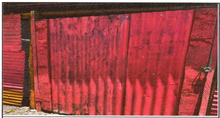
Foto 6: Fabricación e instalación de puerta de metal para acceso a aula.
