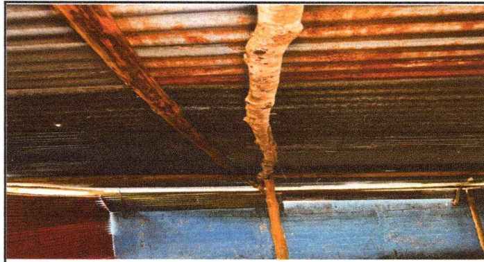
Foto 3: Sustitución de lámina acanalada en mal estado por lámina troquelada aluzinc (cubierta de lámina).
