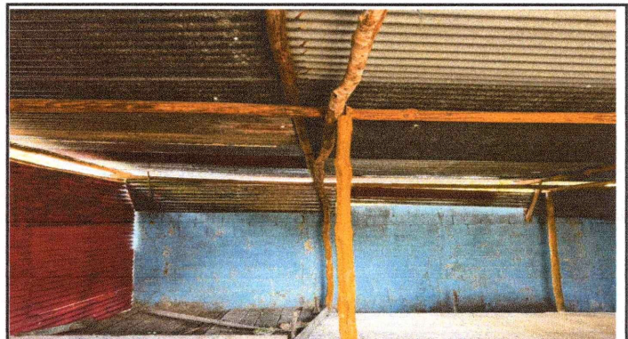
Foto 2: Sustitución de estructura de madera, por estructura de metal para mayor vida útil.
